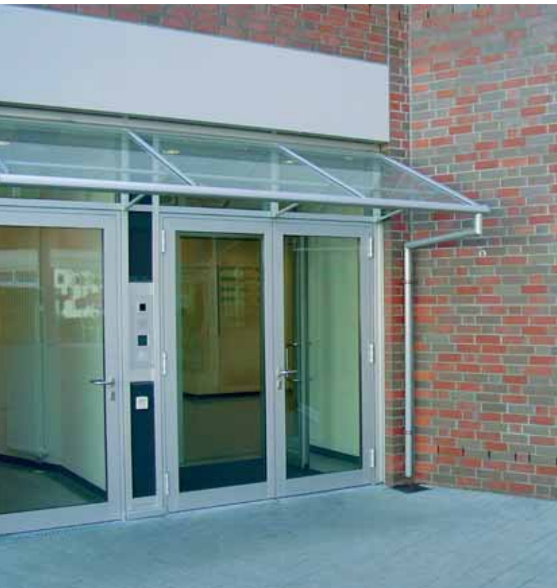
Hamburg_Bürogebäude „Barmer Ersatzkasse“
